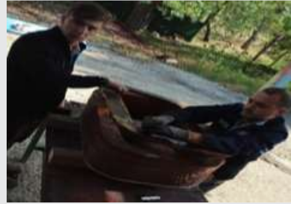
Resim 12: Kutup Sargı Bakım-Onarımı
