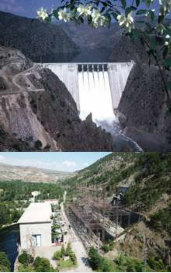
Resim 3: Sarıyar HES Barajı, Şalt Sahası ve Santral Binası
