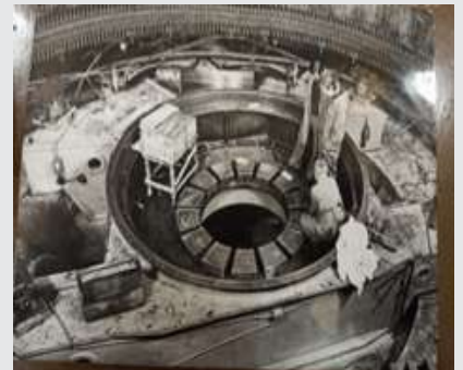
Resim 2: Ünitenin ilk kurulumu sürecindeki taşıyıcı yatak montajı
