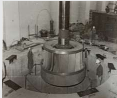
Resim 1: Ünitenin ilk kurulumu sürecindeki türbin çarkı montajı
